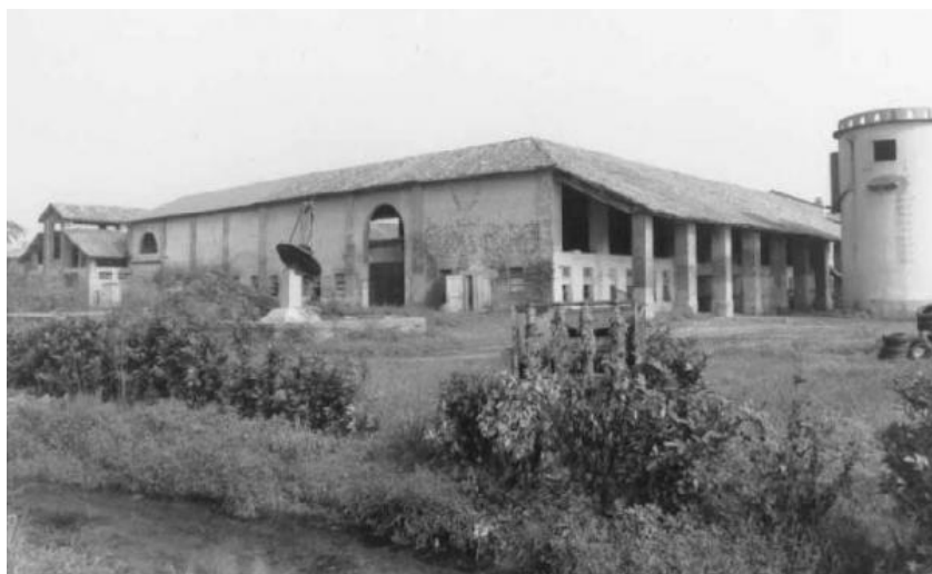
Fig. 62 - Aggregato rurale di Terzago (in alto) - Casa Mainardi (in basso)
