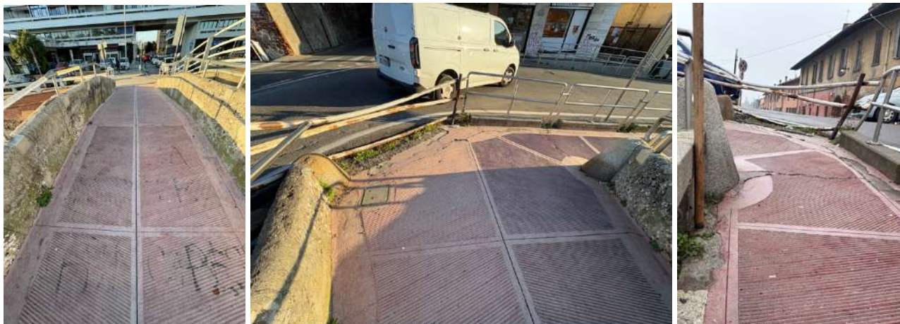
Pavimentazione in cemento
