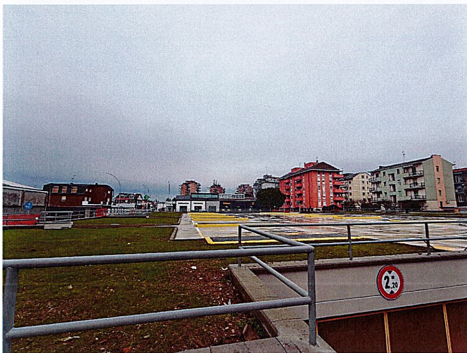
Lavori in fase di completamento
