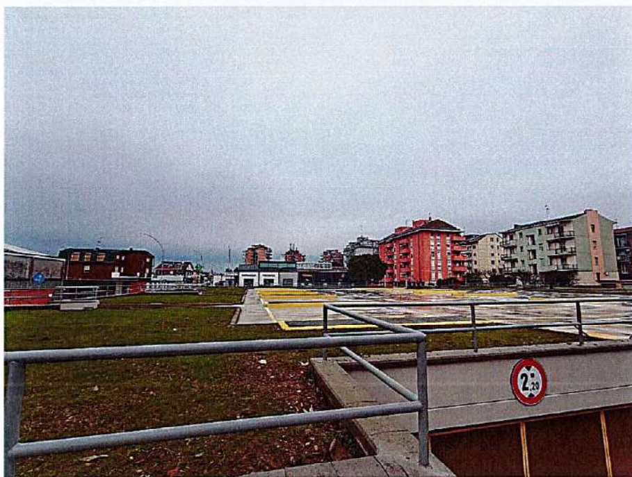
Lavori in fase di completamento
