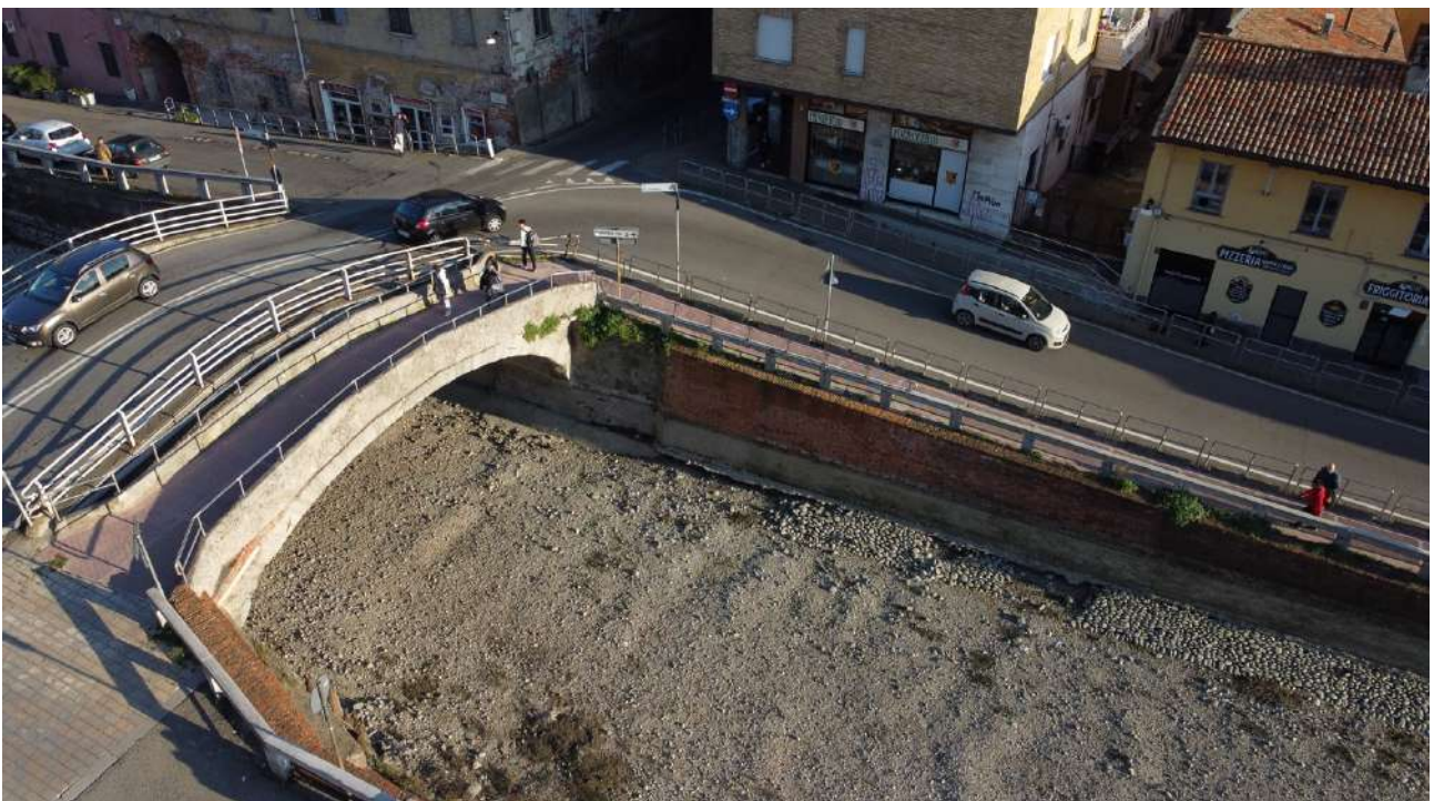
Ponte Gobbo e rampa
