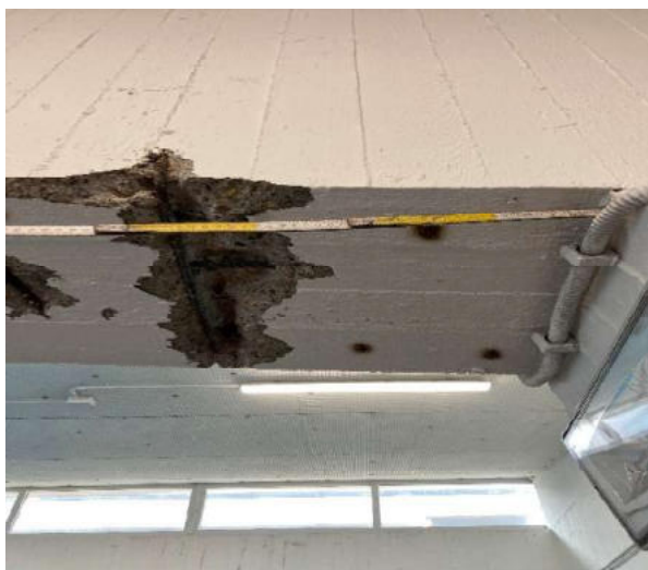
Prelievo armatura da trave in c.a.
