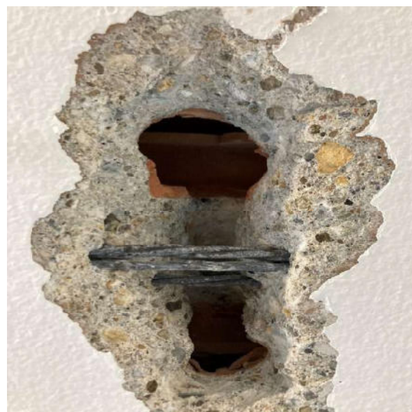
Scasso sul solaio per prelievo trefoli
