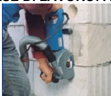
Trattassi di assistenze murarie agli impiantisti
